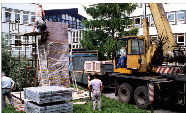
Montaż elementów pomnika
