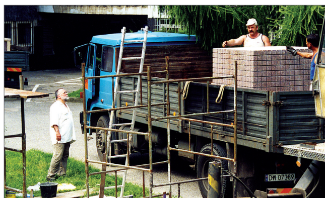
Wyladowywanie elementów pomnika pod nadzorem Eugeniusza Get-Stankiewicza
