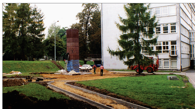
Wyrównywanie terenu pod zagospodarowanie zieleni
